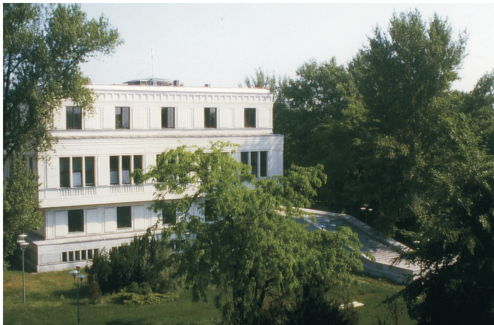
Budynek Senatu – widok od ul. Górnośląskiej. (Fot. J. Zawadzki)
