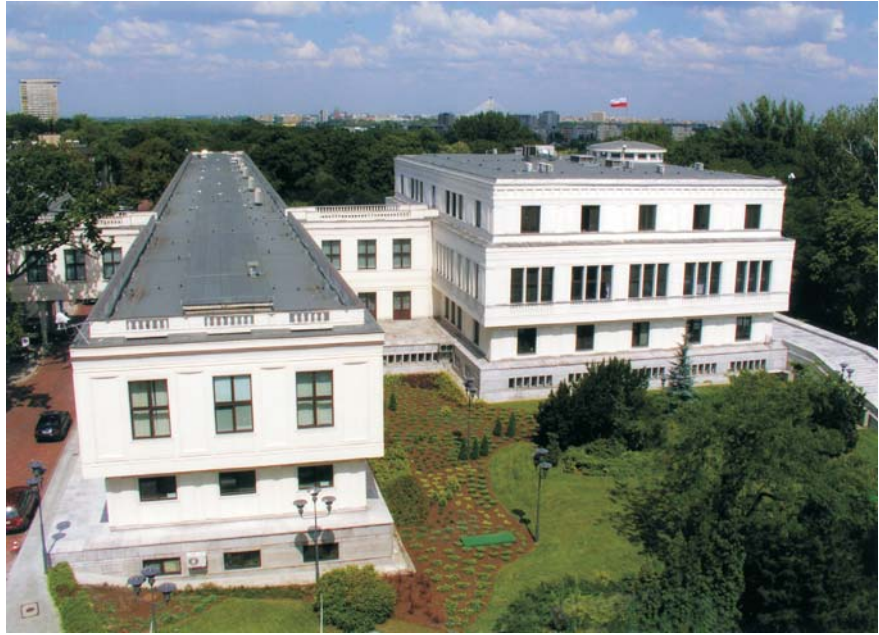
Bâtiment du Sénat du côté de la rue Górnosłaska
