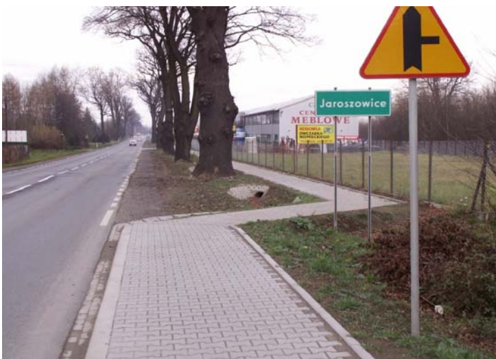
DK 28 m. Jarosławice – budowa ciągów pieszych
