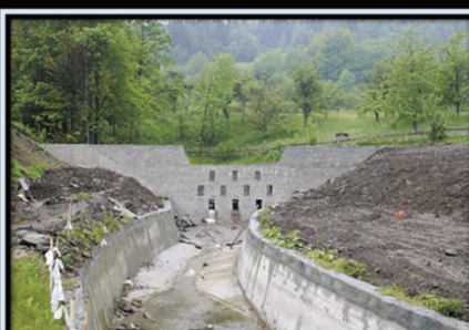
Jedna z najbardziej drastycznych metod regulacji potoku. Takie rozwiązanie powoduje całkowitą zagładę życia biologicznego i wzrost zagrożenia powodziowego dla terenów niżej leżących.
