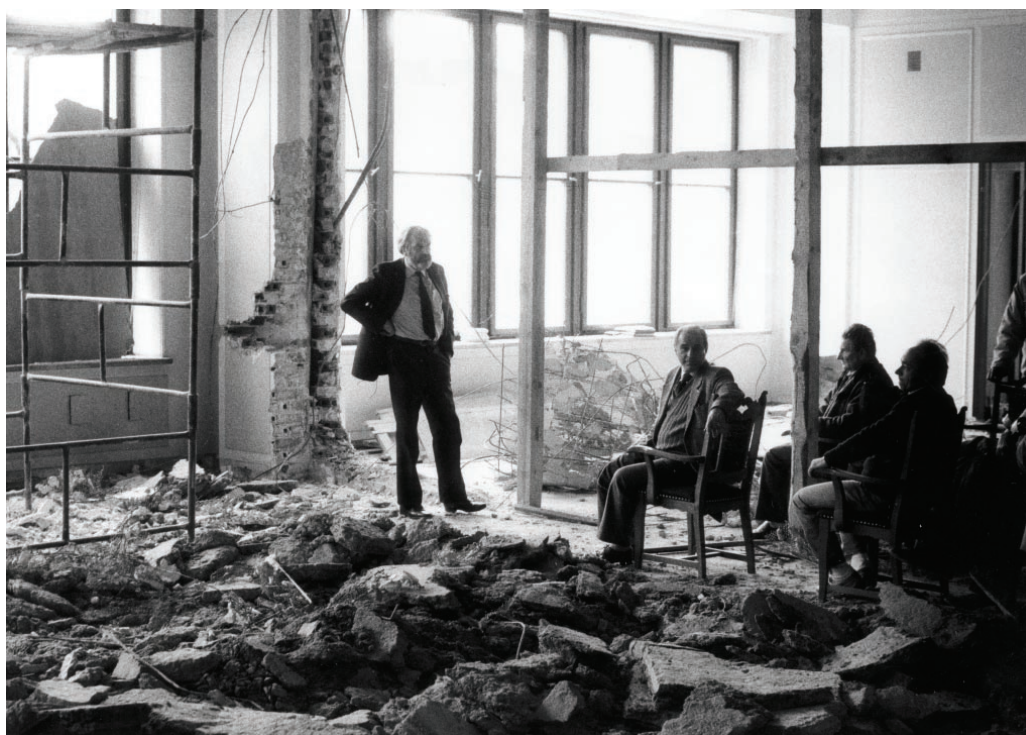
7. Przebudowa pomieszczeń na salę posiedzeń Senatu
