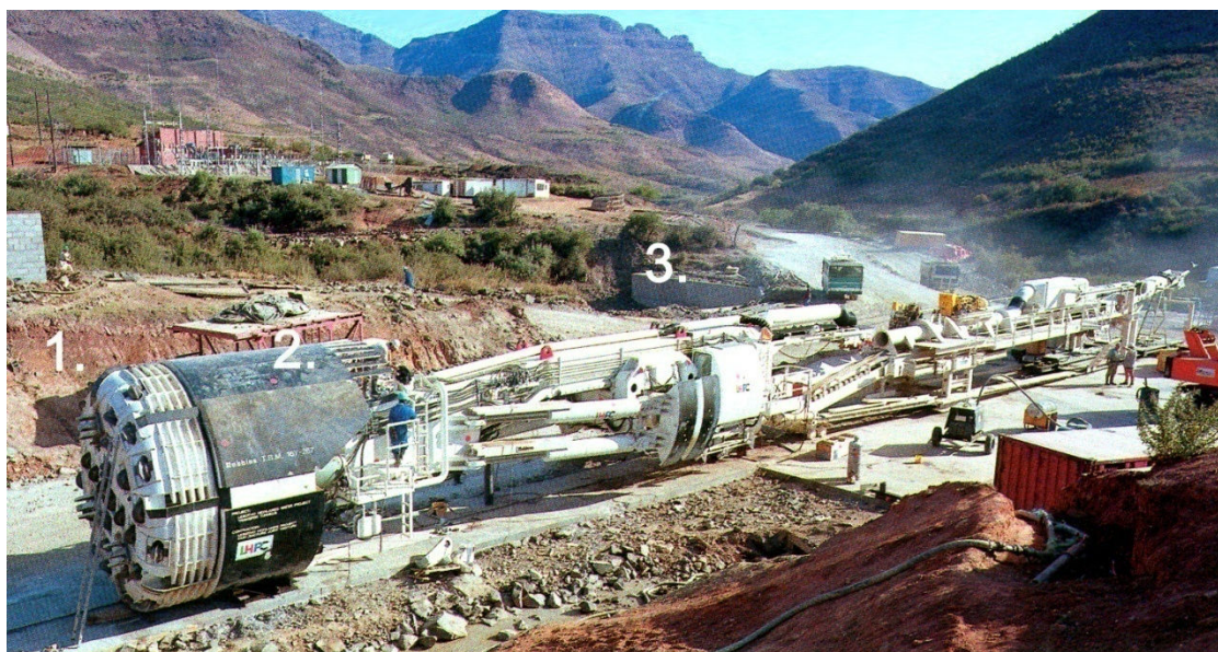
Maszyna TBM przygotowana do rozpoczęcia drążenia tunelu.
